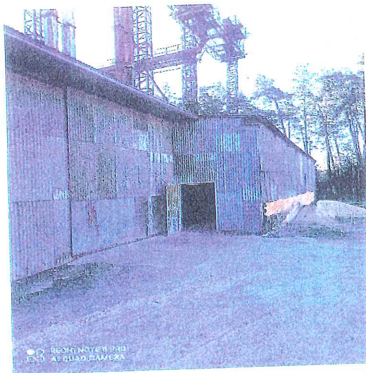
Zdjęcie nr 1 Wiata Magazynowa na odpady – miejsce wstępnego magazynowania wytworzonych odpadów.
