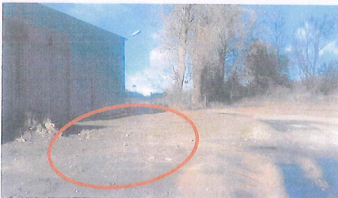
hala nr 1: docelowe miejsce usytuowania instalacji technologicznej (część zewnętrzna)
