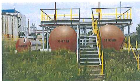
Dwa zbiorniki olejowe leżące po V-50 m 3 oraz jeden o V-10 m 3 .
