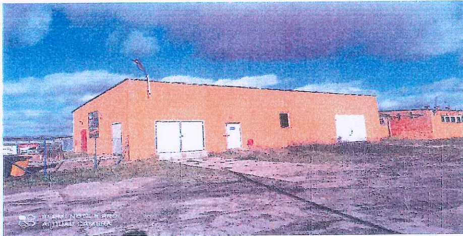
Zdjęcie nr 8 Utwardzony dojazd do drzwi z rampą w budynku przeznaczonym do wstępnego magazynowania odpadów.
