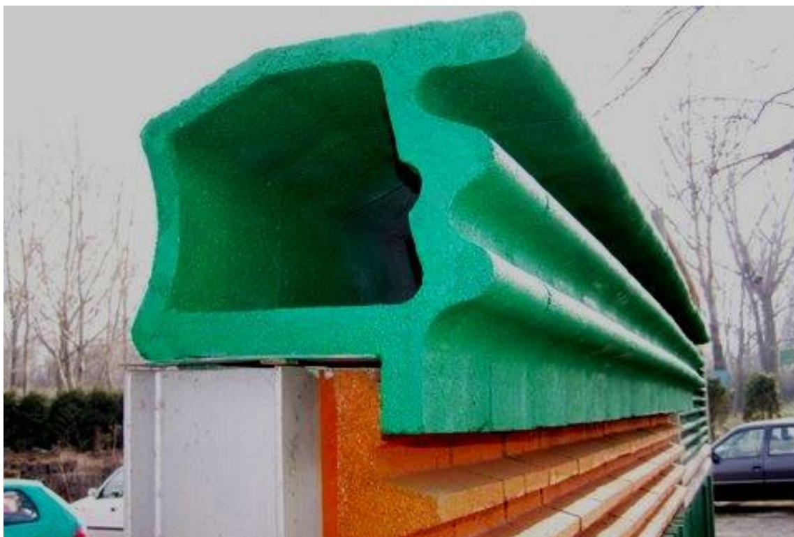
Rysunek 14-9 Dyfraktor zamontowany na krawędzi górnej ekranu akustycznego
