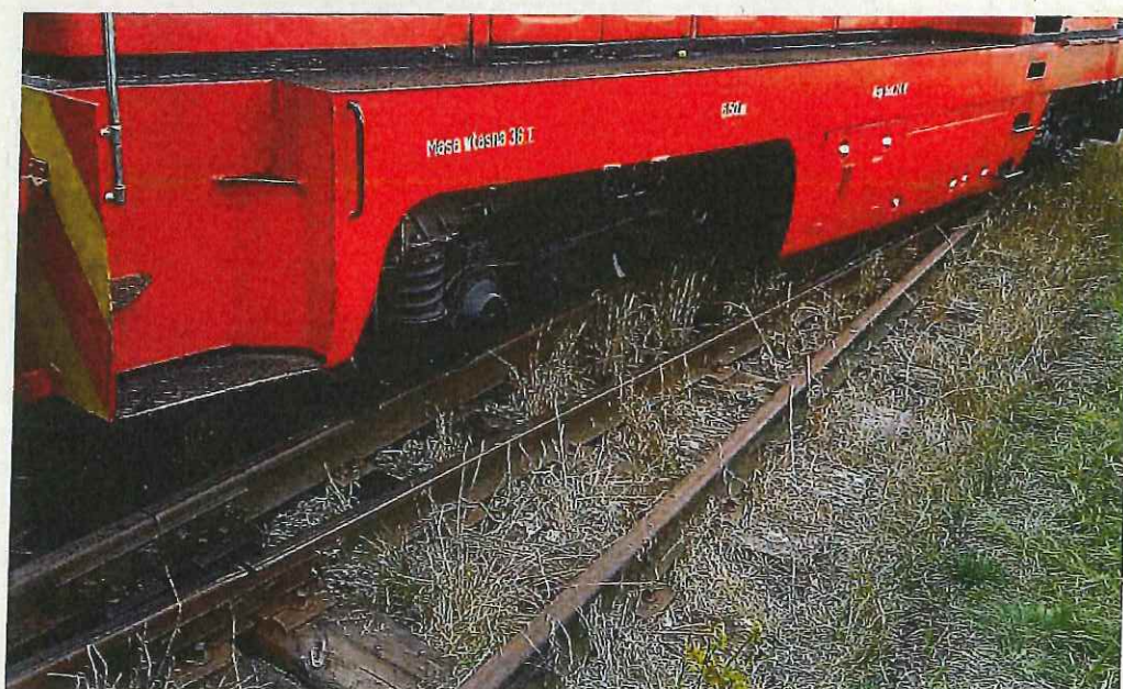
Lokomotywa po wykolejeniu wjechała w rozjazd wyremontowany w zeszłym roku uszkadzając podrozdnice
