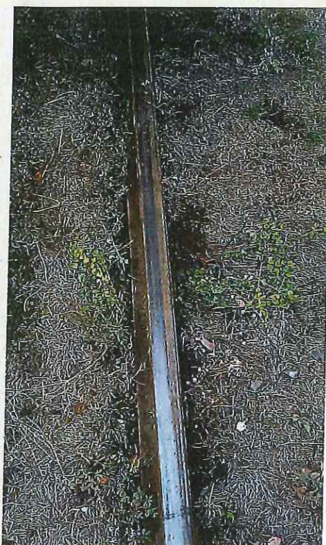
Praktycznie nie można dostrzec podkładów oraz przytwierdzeń szyny – zostały wgniezione w resztki podkładów.
