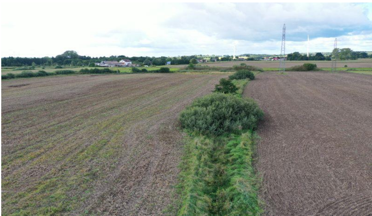
Fot. 1 Rów odwadniający
