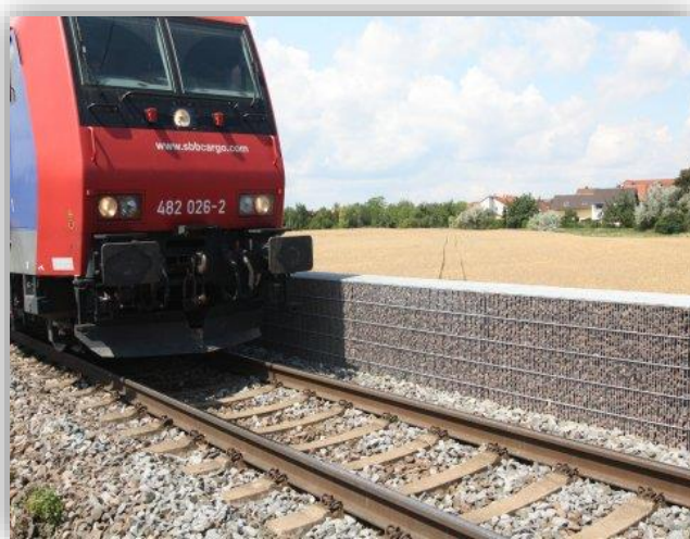
Rysunek 28 Przykładowe zastosowanie niskich ekranów (źródło: https://www.heringinternational.com/en/nc/news/article/for-the-sake-of-the-environment-testing-low-noise-barriers-along-railway-tracks/ )
