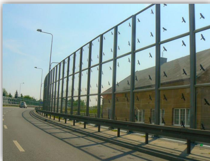
Rysunek 26. Zastosowanie przezroczystego ekranu z akrylu (źródło: http://ro.com.pl/o ogranicza-liczbe-ekranow-dzwiekochlonych-na-drogach/01151290 )
