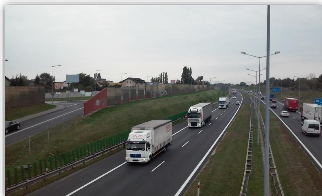
Rysunek 24. Zastosowanie ekranu akustycznego wraz z wałem ziemnym (źródło: zdjęcie własne).
